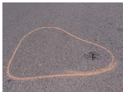
Unoszenie się warstwy ścieralnej na 2-3 cm
